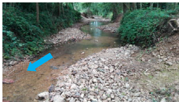
Exemple de restauration sur la Foussarde
